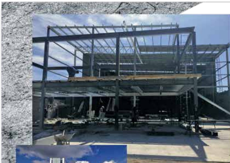
Proyecto en construcción
